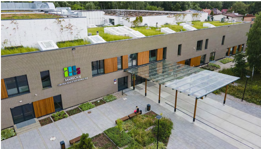
Rys. 2: Budynek MCER Źródło: mareckieinwestycje.pl
